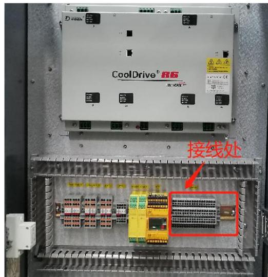
图 2-6 外部急停接线
