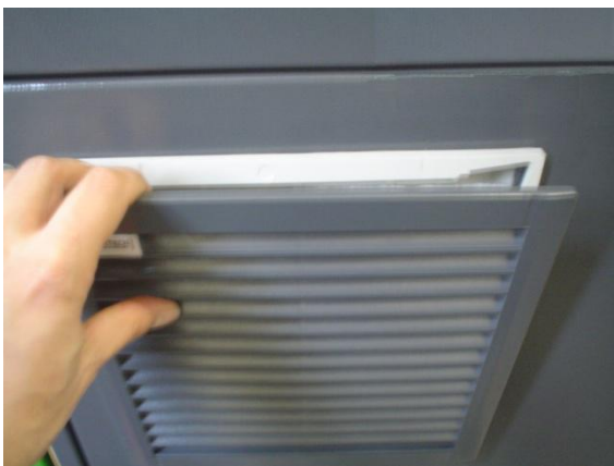
检查和更换滤尘器步骤 1
