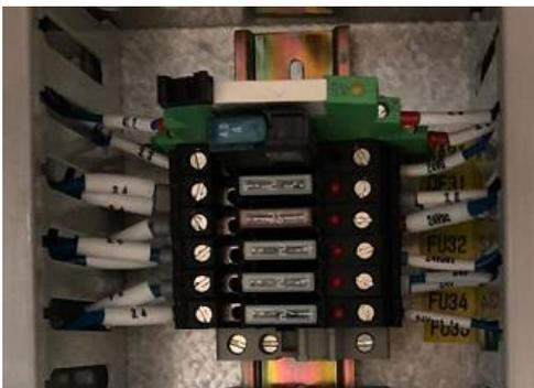
图 4-13 更换熔断器
