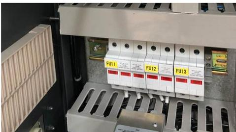
图 4-12 更换熔断器
