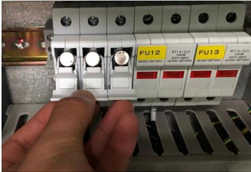
图 4-14 更换熔断器
