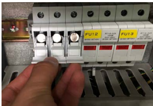
Figure80:Replacing fuses 更换熔断器
