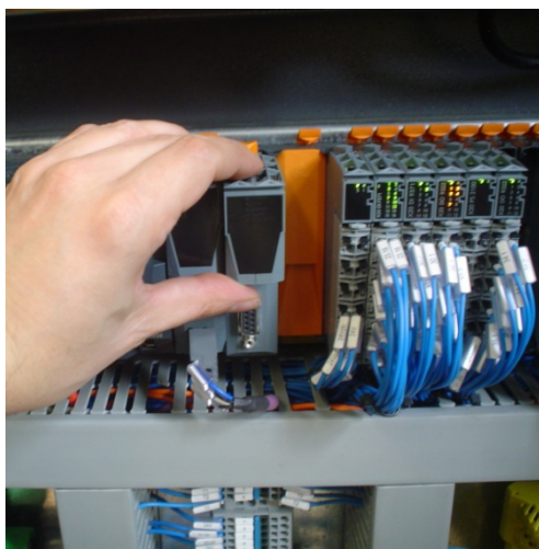
Figure58:Profibus module connection Profibus 模块连接
