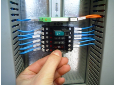
Figure81:Replacing fuses 更换熔断器
